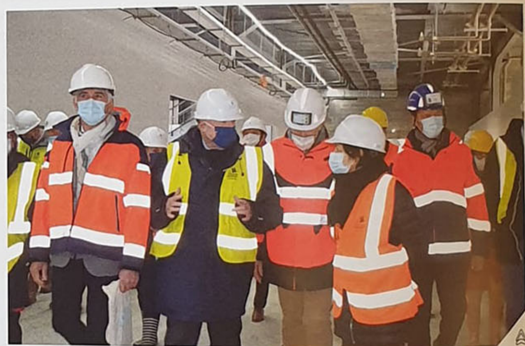
Annick Girardin a fait la visite du chantier du port de la Cotinière, accompagnée par Dominique Bussereau et Christophe Sueur
